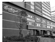
カーム尼崎健診プラザ
